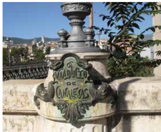
Viaducto de Alcoy sobre el río Molinar, inaugurado en 1907.
