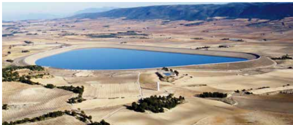
Balsa de la Cuesta. Obra fundamental en el postravase Júcar-Vinalopó.
