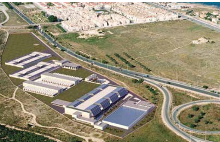
Desaladora de Torrevieja. La mayor de Europa.
