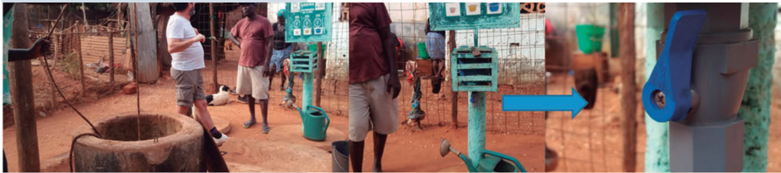
Pozo junto a una cloradora manual. Detalle de válvula dosificadora.
